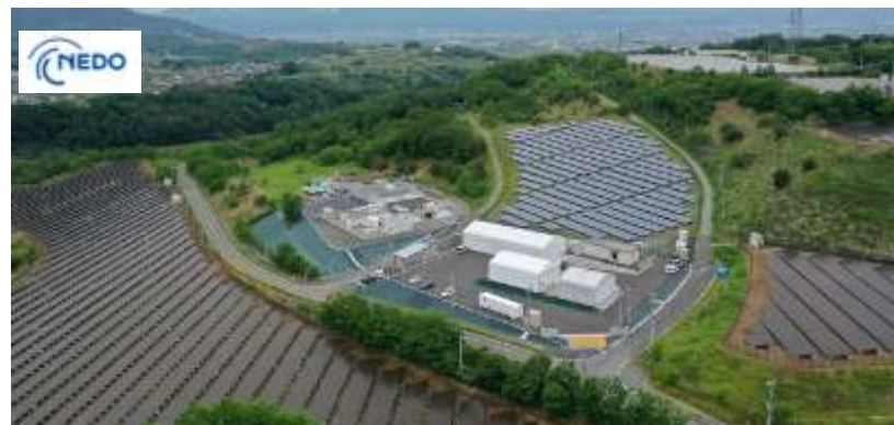
国立研究開発法人 新エネルギー・産業技術総合開発機構 (NEDO) CO 2 フリーの水素社会構築を目指したP2Gシステム技術開発(2016-2022) ※山梨県・米倉山電力貯蔵技術研究サイト 全景 ©山梨県企業局
