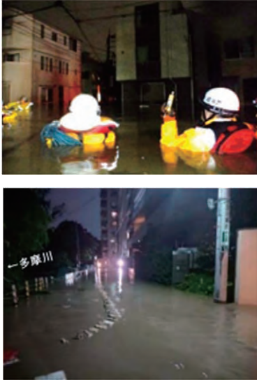
図表 1. 台風による浸水被害の様子 (出典 1)
