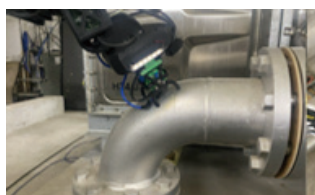
パイプの検査
