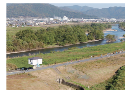
ドローンが撮影したリアルタイムの映像
