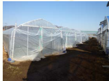
農薬散布軽減型パイプハウス
