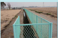
安全施設の整備
