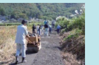
土砂道の補修
