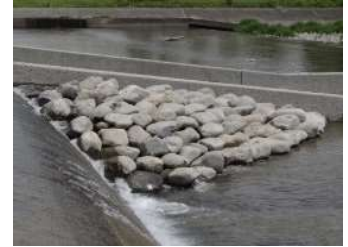
石組み魚道(日野用水堰)
