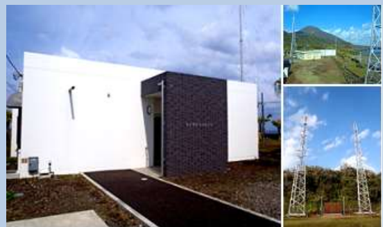
漁業無線局 局舎(八丈島)と、送受信アンテナ
