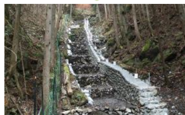
奥多摩町のワサビ田 (上段：被災時、下段復旧後)
