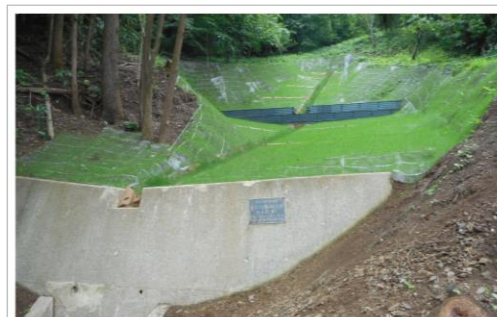
令和元年台風 19 号による崩壊地の復旧（八王子市内）
