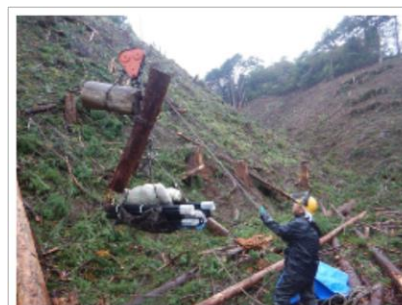
架線を用いた防護柵資材とコンテナ苗の運搬
