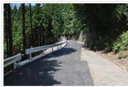
復旧工事完了後
