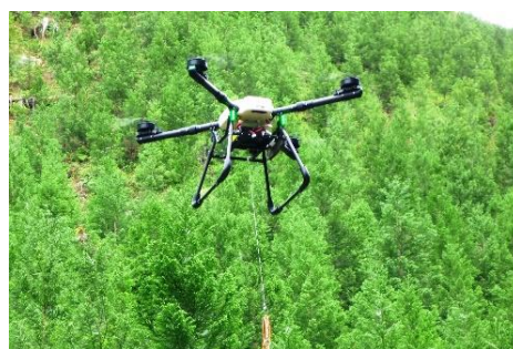
防護柵の資材を運搬するドローン
