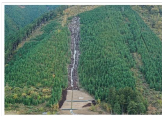
治山事業による復旧
