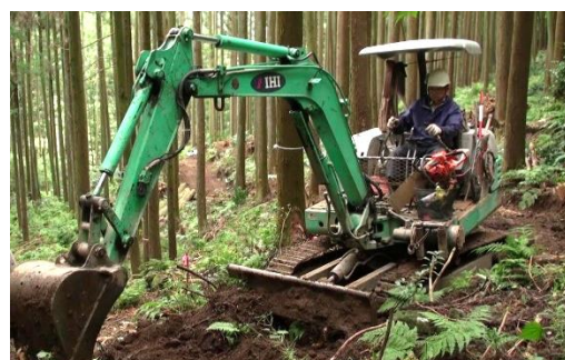
森林作業道を整備する技術者
