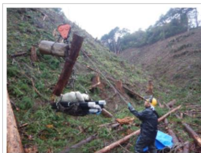
架線を用いた防護柵資材とコンテナ苗の運搬
