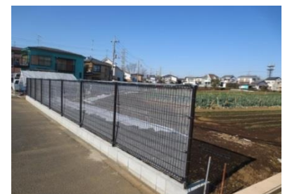
土留め、フェンスの設置
