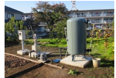
防災兼用農業用井戸の設置
