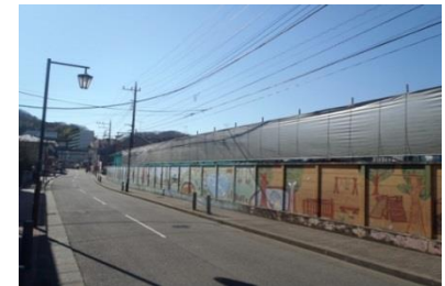
農薬飛散防止施設の設置
