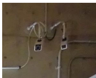
監視カメラの設置
