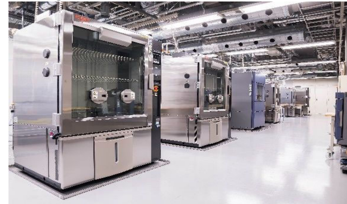
綿密な事前調査、設計に基づき、サービス停止期間を最小限にした改修工事を実施
