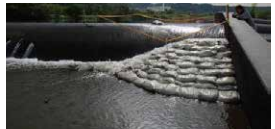
図 3 土嚢式簡易魚道
