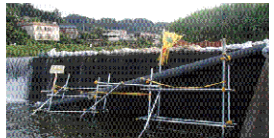
図 2 ハーフパイプ式簡易魚道
