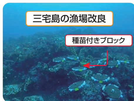
テングサの繁茂を促進するため、投石漁場にテングサ種苗付きブロックを設置
