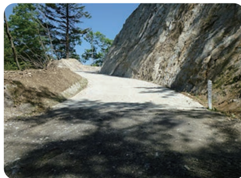
写真1 板東沢丹田林道の開設箇所
