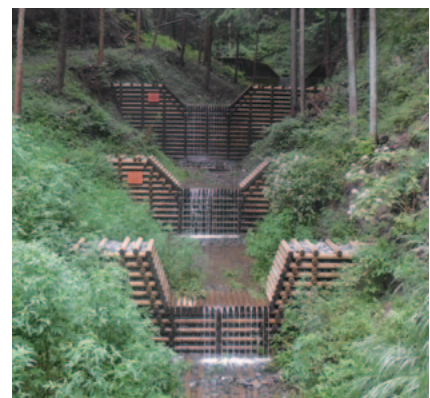
写真2：木製校倉(あぜくら)式治山ダム (木材を活用した治山ダム)
