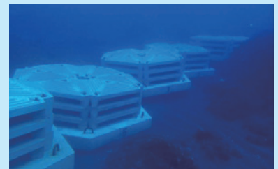
コンクリート製の藻場礁(大島)
