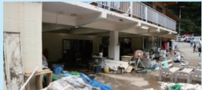
豪雨による浸水被害を受けた施設(秋川漁協:令和元年)
