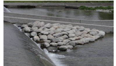
石組み魚道(日野用水堰)
