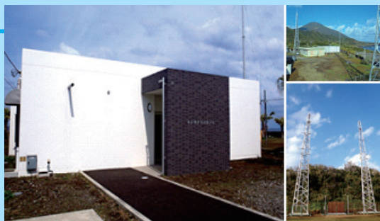
漁業無線局 局舎(八丈島)と、 送受信アンテナ
